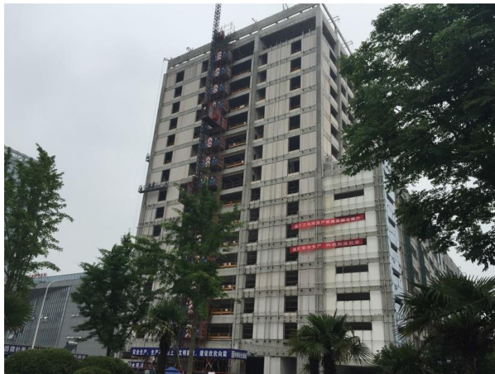
立体停车楼近景照片
