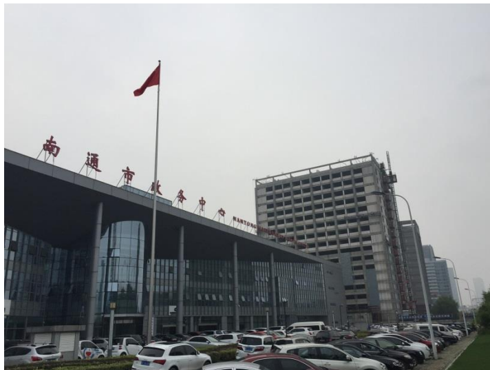
立体停车楼远景照片
