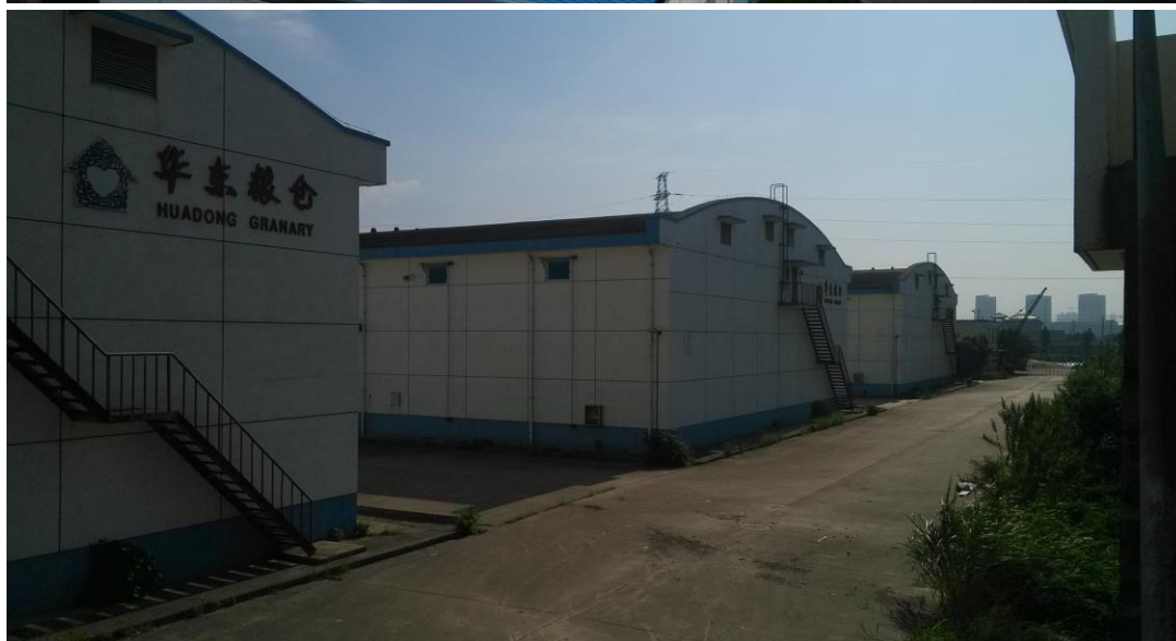
改造前的低效破产企业厂房
